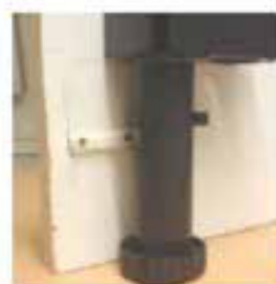
Avstand fra festeplate til ende av sokkel: minimum 12 mm
